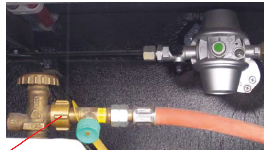
Kaasupullon liittimissä on vasenkätiset kierteet
