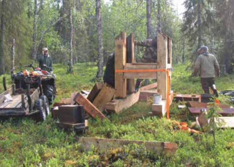
The construction work at the Site of Kirkkokuusikko. Photo: Mirja Hiltunen
