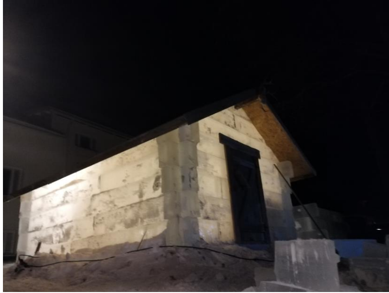
Kuva 15. Jäähirsistä valmistuva mökki Apukka Resortin ympäristössä. Koivu, 2018, Valokuva.
