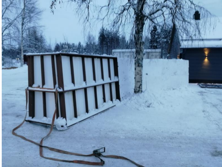
Kuva 16. Lumimuurin kasauksessa käytetty muotti.
