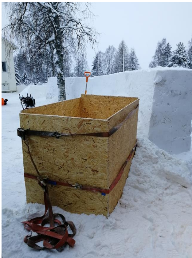
Kuva 18. Lumen kasaaminen levyjen ja kuormaliinojen avulla.
