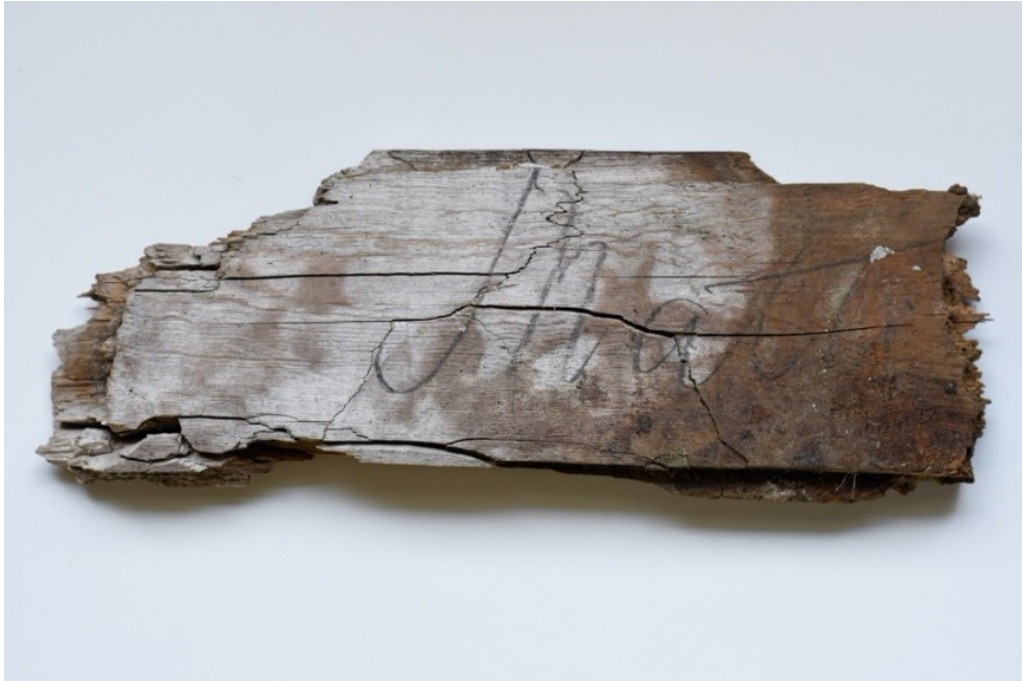
Kuva 5. Helena Keskitalo löysi kesällä 2019 Alatalon navetan raunioilta laudan kappaleen, jossa lukee navetan rakennuttajan Matti Alatalon nimi. Navetta rakennettiin 1920-luvulla.
