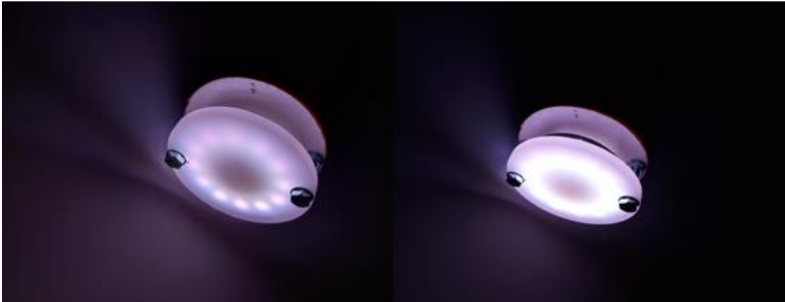
Kuva 32. Opaalivalkoinen akryylilevy suodattaa ja pehmentää valoa.
