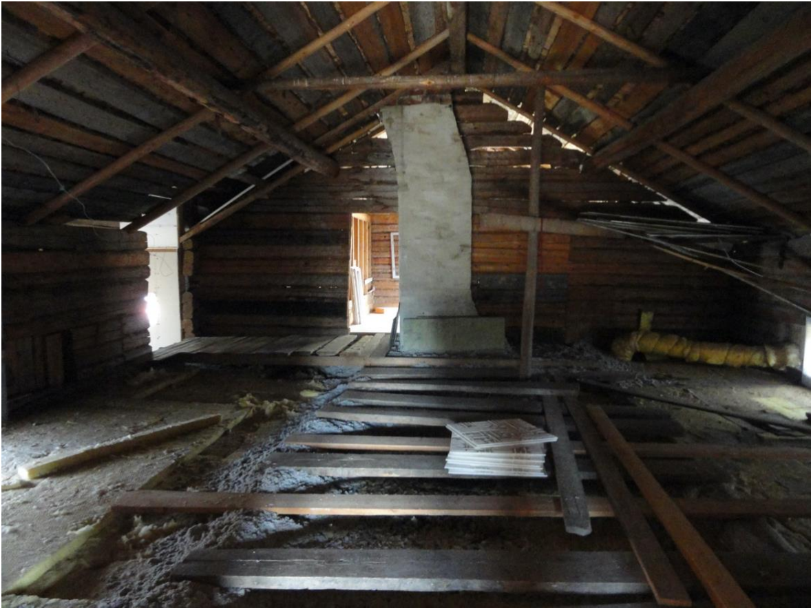
Kuva 9. Punttilan vintti ennen asuttavaksi rakentamista. (Virpi, 2015)
