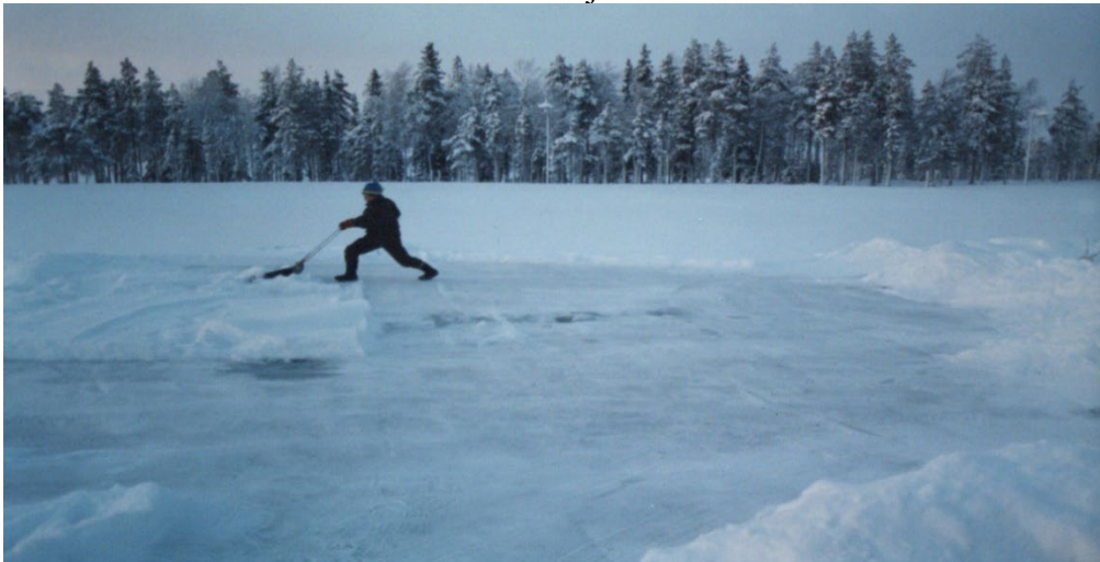
Kuva 7. Kaukolammen puiston työmaalla
