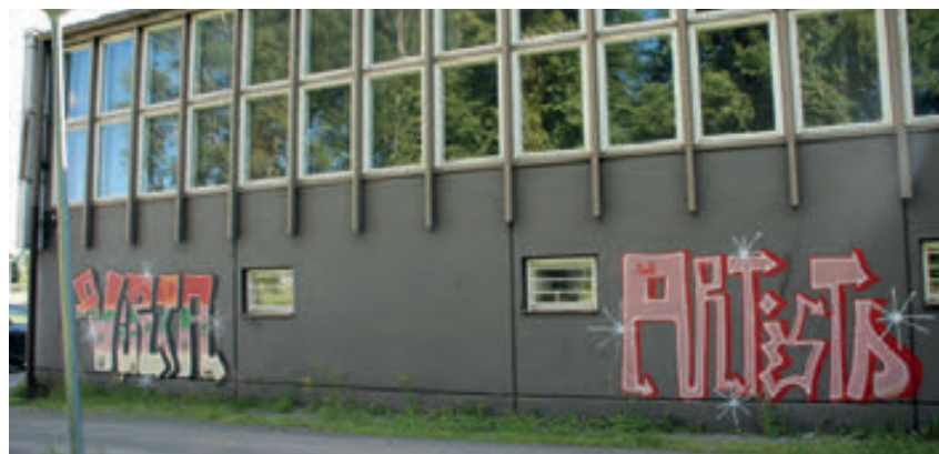
Kuva 36. Purettavan koulurakennuksen seinä 2007
