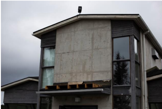
Kuva 15: Jyrki Tammi 2018. Rakensin seinän eteen työskentelytason, joka helpotti työskentelemistä kaltevan sadekatoksen päällä.
