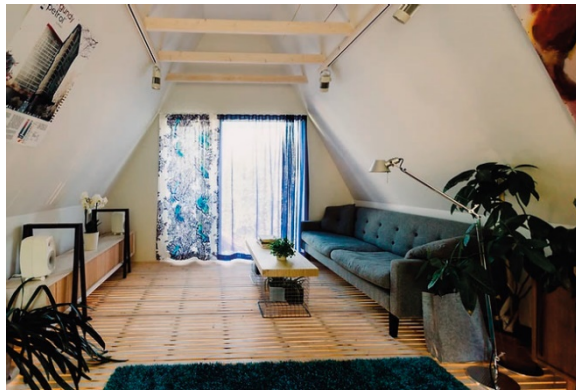
Kuva 13 Yläkerran huoneen lattia on toteutettu valoa läpipäästävällä rimoituksella. Enne 2020.
