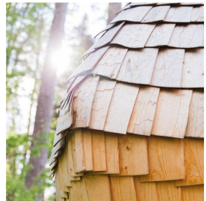
Kuva 22 Luomukodin rakentaminen on toteutettu täysin liimattomasti perinteisillä rakennusmenetelmillä. Goltz 2020.
