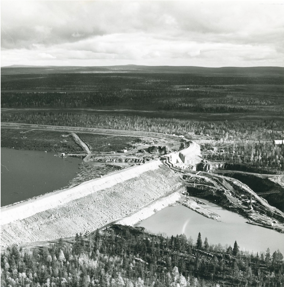
Kuva 006. YIT urakoima Porttipahdan pato ja uittoränni 1970-luvun alussa. Voimalaitos rakennettiin 1970- ja 1980-lukujen taitteessa. Voimalaitoksen urakoi Pohjansepot Oy. Pääsuunnittelija oli DI Ossi Mustonen, työpäällikkö DI Jouko Alapoikela ja päävalvoja insinööri Martti Aaltonen. Valokuva ELKA. Kemijoki Oy. 11742.
