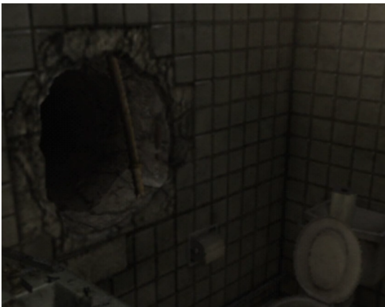
Kuva 51: Vessan seinään ilmestynyt reikä. Ruutukaappaus.
