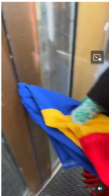
Kuva 5. Kuvakaappaus liukuovien väliin jääneestä lipusta (NSR Nuorat 2023)
